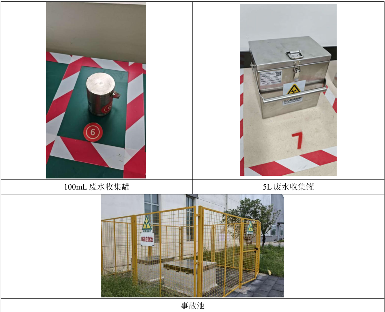
图 3-15 废水处理措施照片
